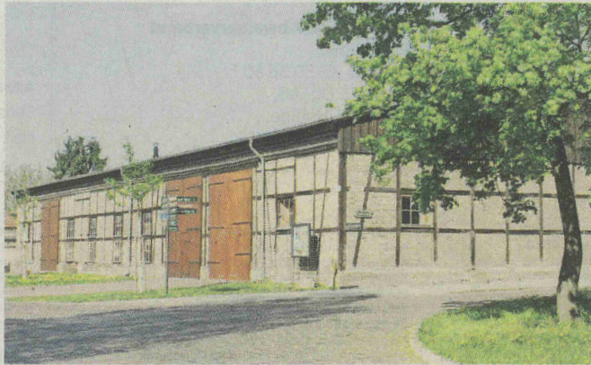
Die Scheune in Paretz.
