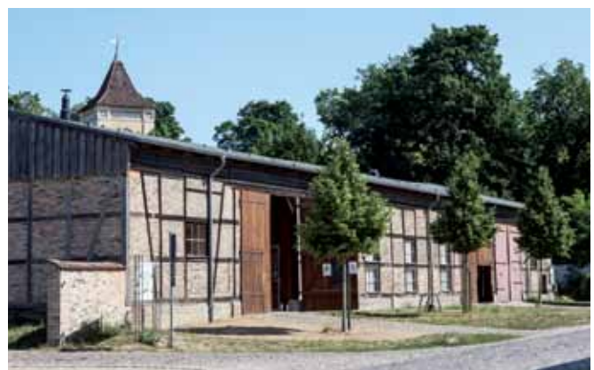
Die denkmalgerecht sanierte Kulturscheune in Paretz
